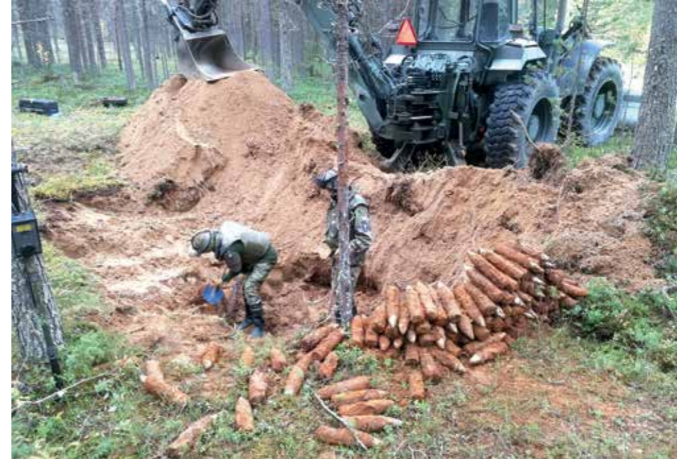
Räjähteiden esiin kaivaminen koneellisesti nopeuttaa raivaamista. Kuva: H Pelkonen
